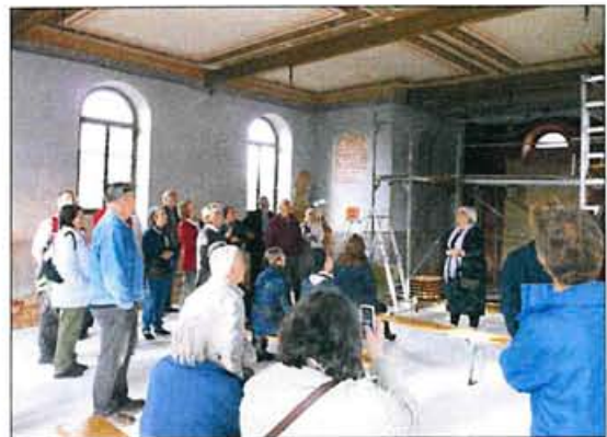
Noch Baustelle: Ehemalige Synagoge Steinsfurt Führung durch die 1. Vorsitzende Jutta Stier
